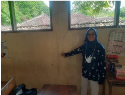
Gambar 2. Retakan Dinding.
